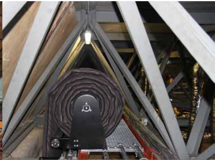
Met extra hijspunten worden de baffles om de regiecabine heen geslagen. Rechts de opgerolde baffle boven het akoestisch plafond. | FOTO: © FRANS VAN OEKEL
