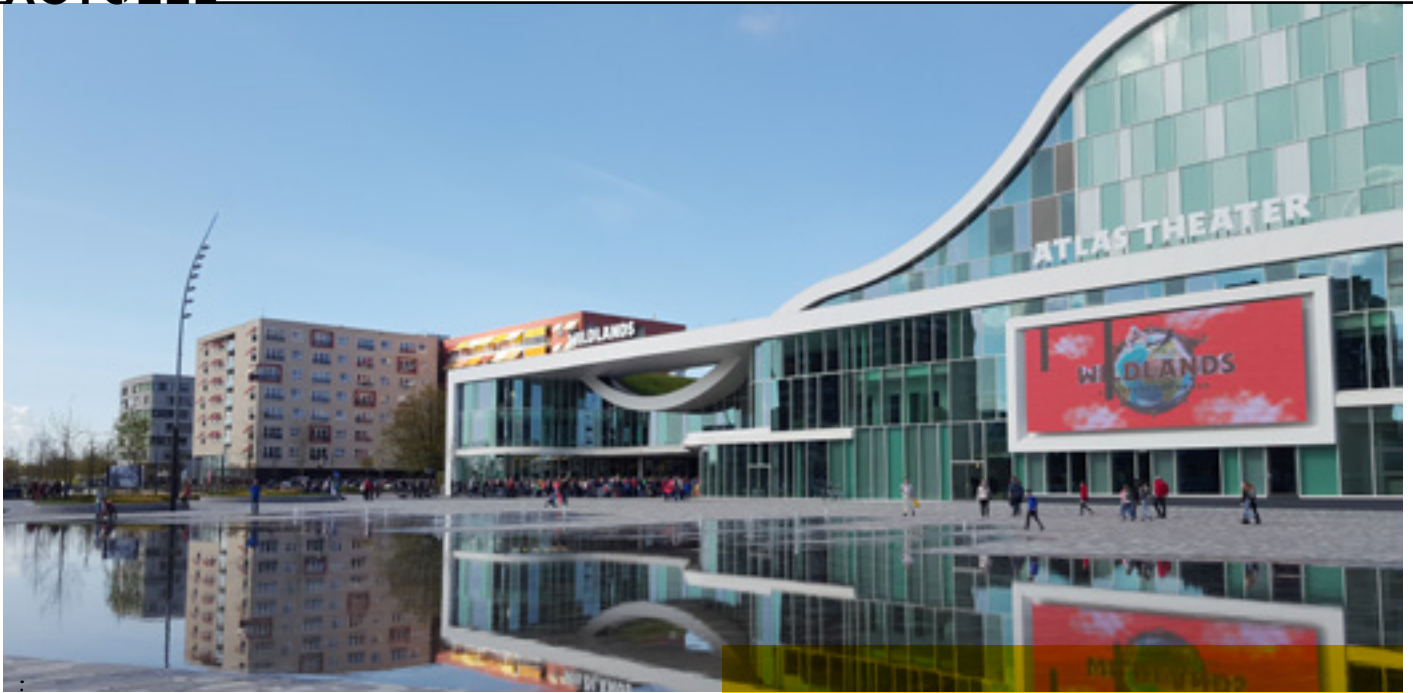
Het nieuwe ATLAS Theater in Emmen en de entree van het vernieuwde dierenpark zitten onder één golvend, groen begroeid dak.
