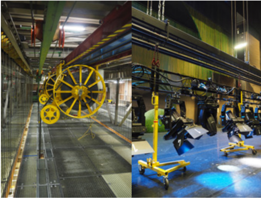
Links: De verplaatsbare kabelhaspels op de rollenzolder van Nationale Opera & Ballet.
